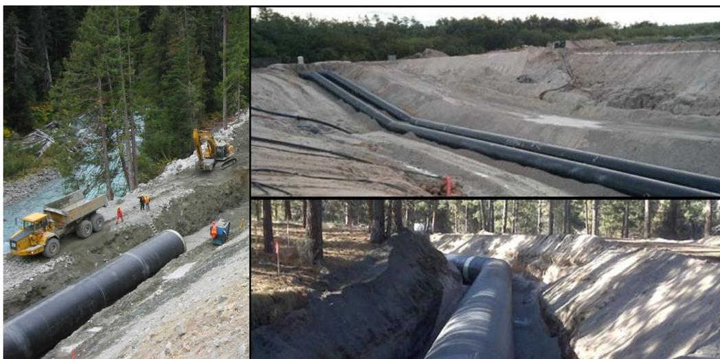
Pour savoir si une conduite gravitaire convient à l'usage prévu, on évalue sa capacité à supporter de façon sécuritaire le poids de la charge d'enfouissement. Cette méthode d'évaluation est décrite en détail dans divers manuels sur les tuyaux en plastique et dans les codes de construction des ponts de l'AASHTO et du Canada.
