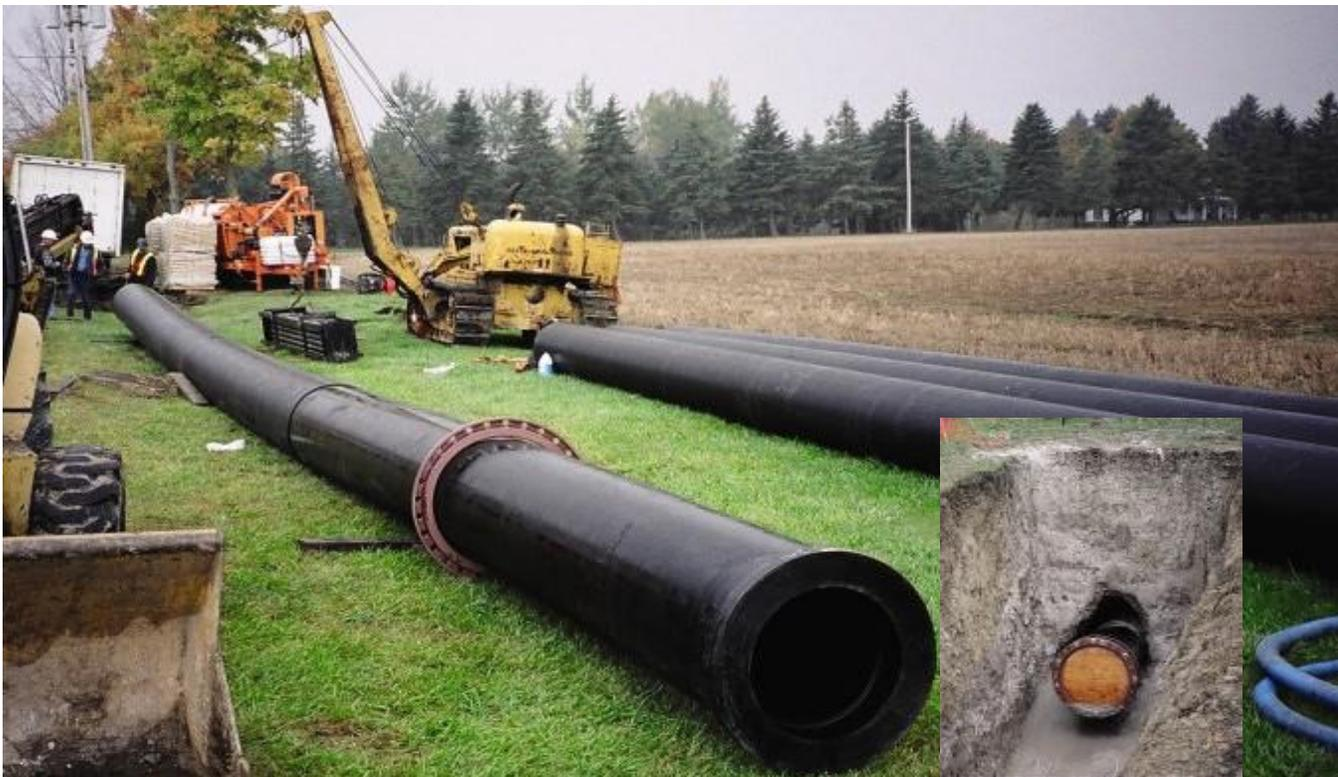
*Les tuyaux Sclairpipe stockés dans l'un des 12 retraits horizontaux du forage directionnel pour le projet.*
