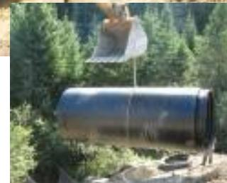
Le tuyau Weholite de 78 po de diamètre intérieur est abaissé en place.
