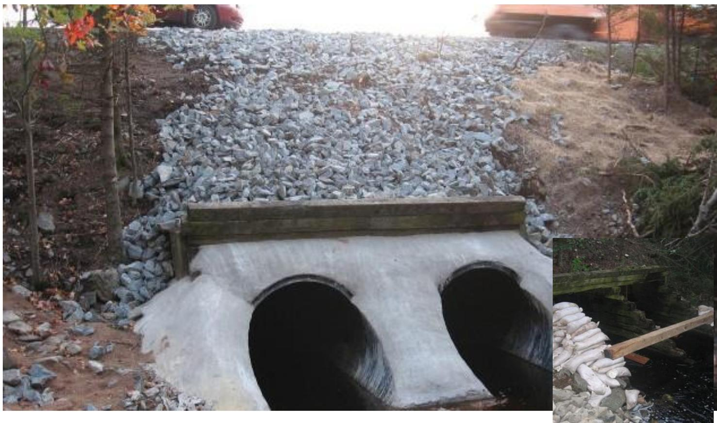
NST&IR choisit une méthode de construction sans tranchées pour restaurer un ponceau à dalot en bois défaillant sous l'une des autoroutes les plus fréquentées de la Nouvelle-Écosse. Le projet situé le long de l'autoroute 102 exigeait le tubage d'un ponceau à dalot en bois de 1,83 m de haut, 3,66 m de large et 38 m de long avec 2 tuyaux RSC250 Weholite de 54 po sur 125 pi par l'entrepreneur.
