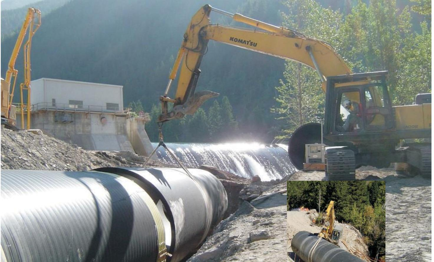
Infra Pipe a haussé la barre dans l'industrie des tuyaux en polyéthylène en produisant des tuyaux Weholite pour le projet de réaménagement du barrage d'Aberfeldie.
