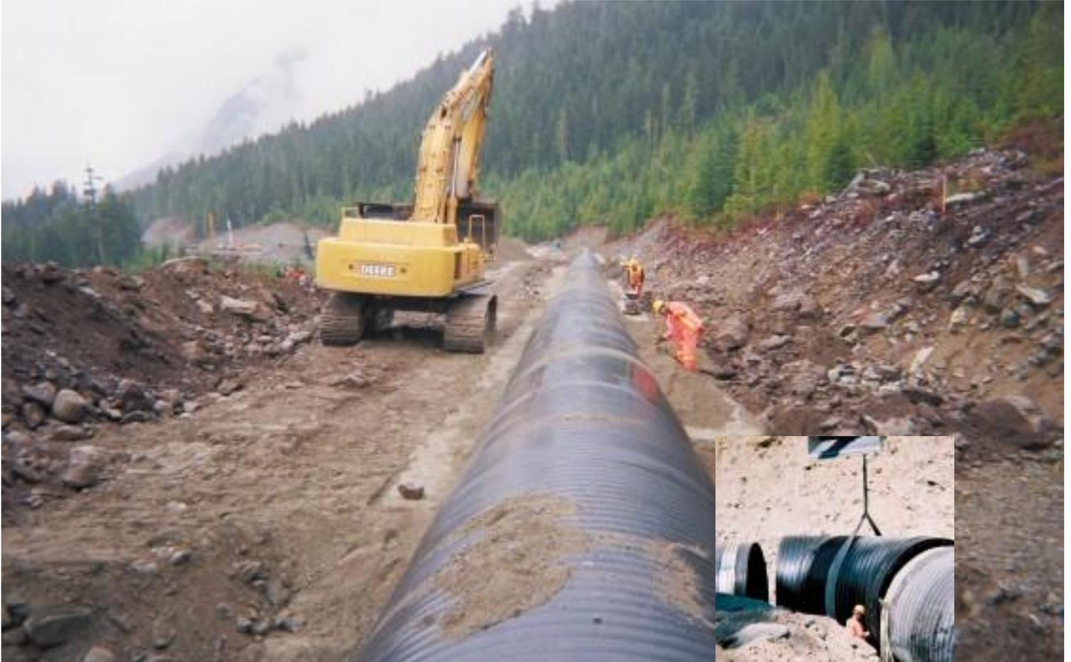
**Le système de tuyaux Weholite transporte l'eau du ruisseau Rutherford Creek sur 3,5 km (1 988 mi) vers le site de la centrale électrique.**
