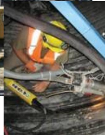
L'équipe d'Uponor effectue une soudure sur le terrain sur l'un des pipelines Weholite
