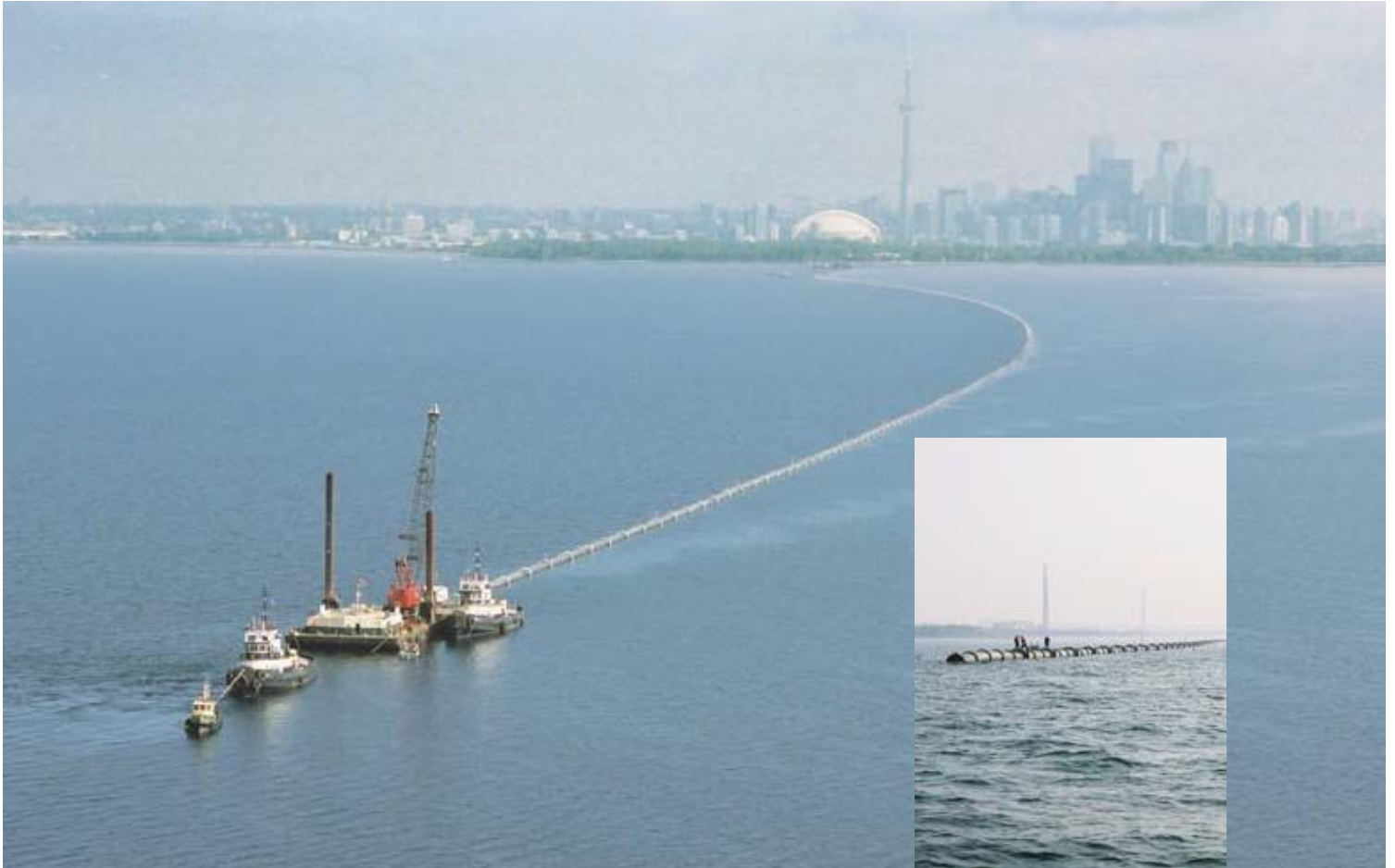
Tuyaux Sclairpipe prêts à l'installation immergée
