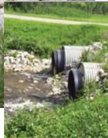
Tubage avec tuyaux Weholite dans deux ponceaux métalliques abîmés
